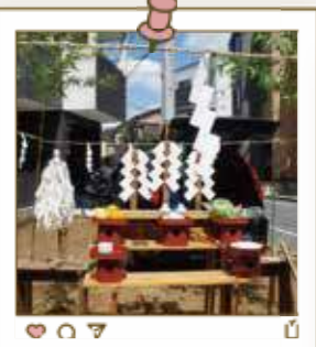
地鎮祭を迎えることができました！完成は〇月の予定！ワクワク。 #地鎮祭 #マイホーム建築中 #おうちづくり記録
